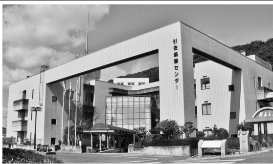
地域遺産センターに改修される引佐協働センター。施設の規模は鉄筋コンクリート造3階建て延べ約3000平方メートル。床の加重を考慮し、1階を24時間空調が必要なブロンズや絵画などの収蔵庫に充てる。2階を事務局や郷土資料の展示室、3階を常温管理可能な民俗文化財などの収蔵庫として活用する。協働センター機能は隣
