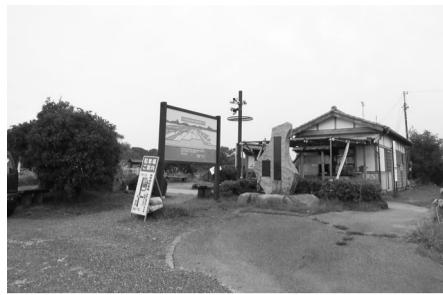
蓬萊橋周辺の現況
