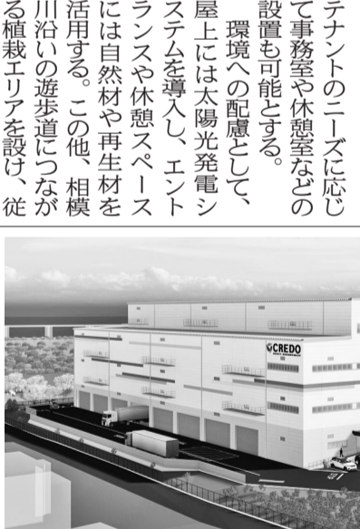
建設地は厚木市戸田2446の敷地8092平方メートル。新東名高速道路の厚木南インターチェンジから約1キロの場所にある。同社は21年3月に設立した物流施設「デベロップ」には初弾物件の「CREDO桶川伊奈」(埼玉県伊奈町)が完成した。今回着工した「CREDO厚木」は神奈川県内の第1弾物件となる。今後は冷凍冷蔵倉庫や危険物倉庫の開発も視野に入れてい
